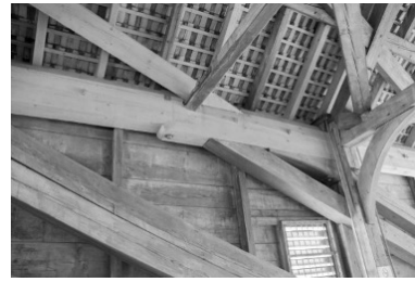
Bis zu 12m lange Tannenbalken wurden verbaut.
