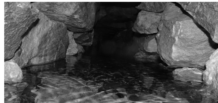
Die ursprüngliche Wasserleitung ist mit Steinen seitlich begrenzt und mit Steinplatten abgedeckt.
